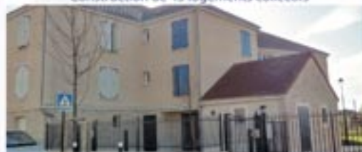
Construction de 45 logements collectifs
